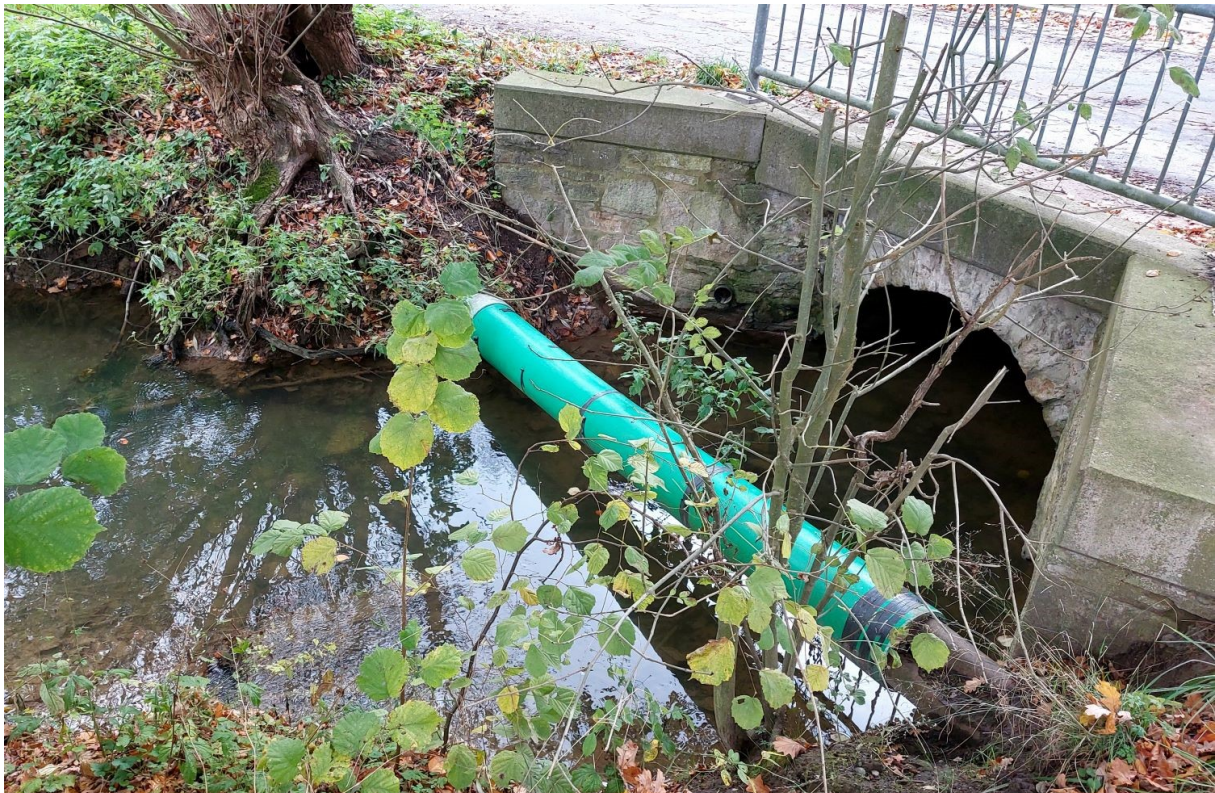
Anstau des Schwarzbach mit Durchlass unter der Straße zur Mühle. Foto: BUND
